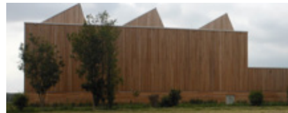
Bâtiment de stockage de l'entreprise Pochecho en structure bois-béton © Ingebois
