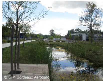
Systeme de noue à Vert Castel
