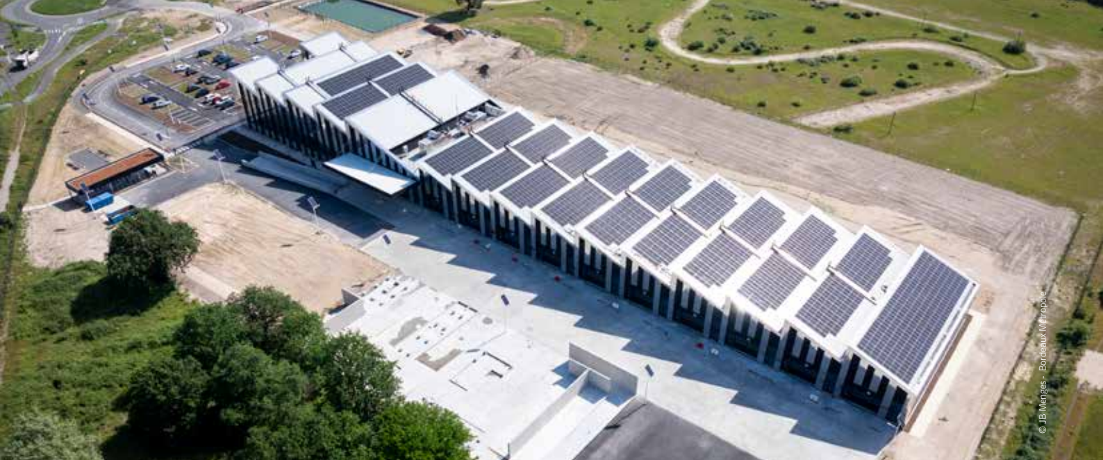
Intégration des panneaux photovoltaïques en toiture sur le siège et la halle productive d'Hydrogène de France à Blanquefort (7 000 m 2 de surface de plancher)
