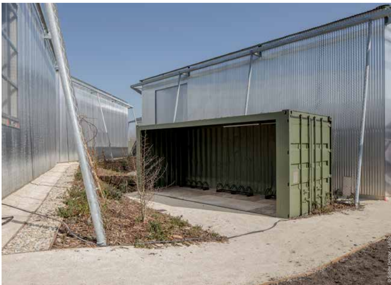
Container transformé en abri vélo dans la zone d'activités Silva à Eysines
